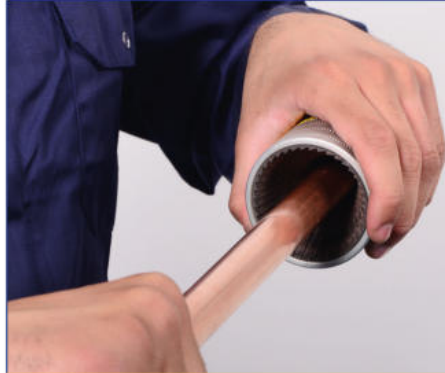
2. Rohr entgraten
