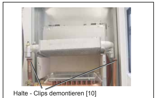
Bild: Demontage Heizwasserwärmetauscher
